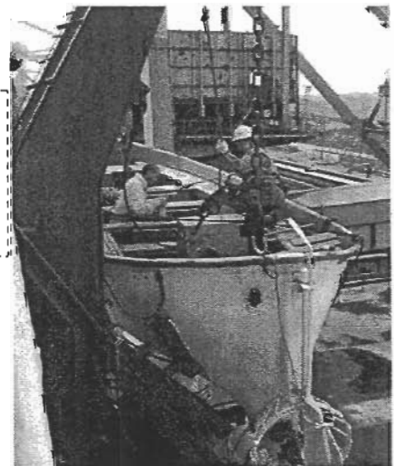
PSCの現場(救命艇の確認)
