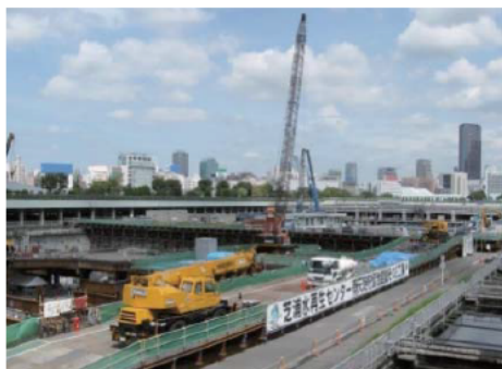
施工状況 (平成24年8月)
