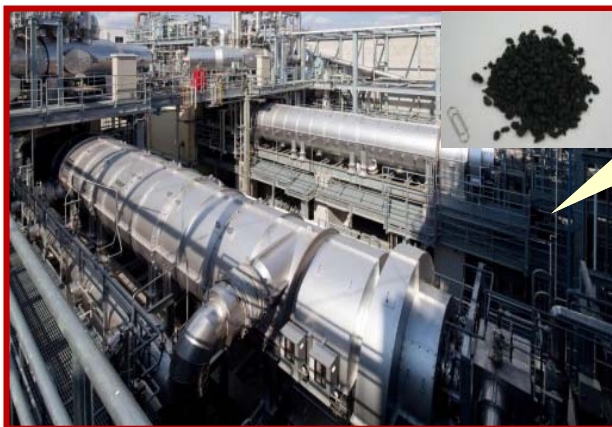
広島市西部水資源再生センター
