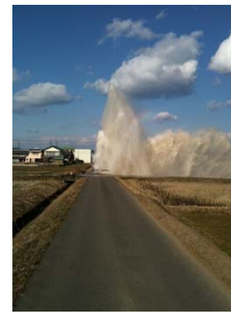
老朽化による送水管破裂事故
