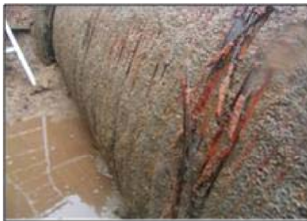
PC鋼線の破断
