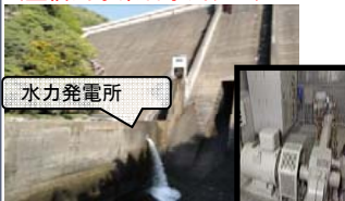
水力発電設備
