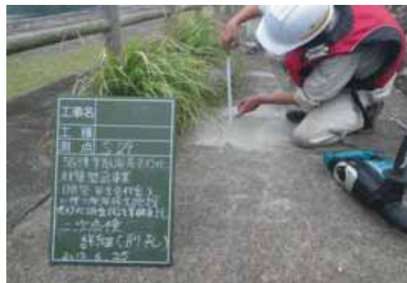
中詰材吸出し状況確認
