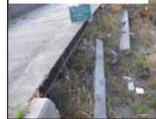
裏法被覆工の破壊、天端の沈下
