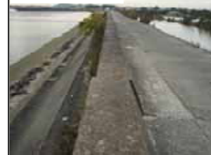
天端のずれと沈下
