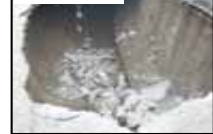
堤体の陥没
