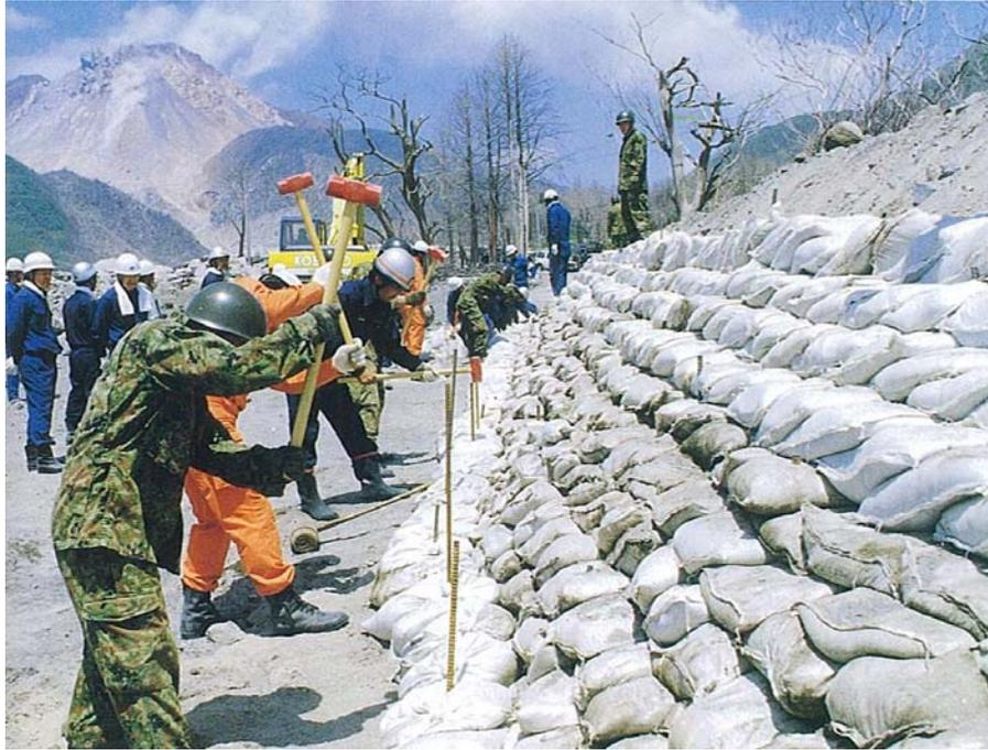
図 6 土のう積工の施工
