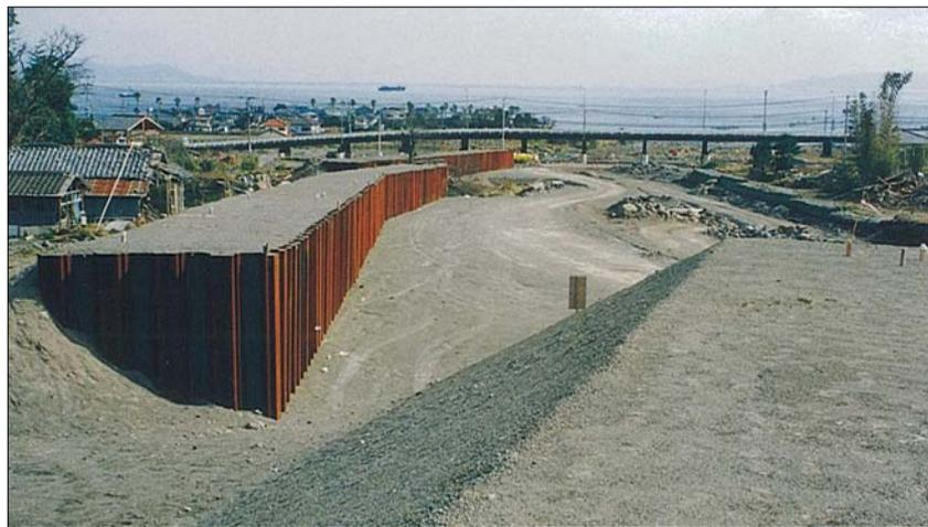
図 9 導流堤の施工
