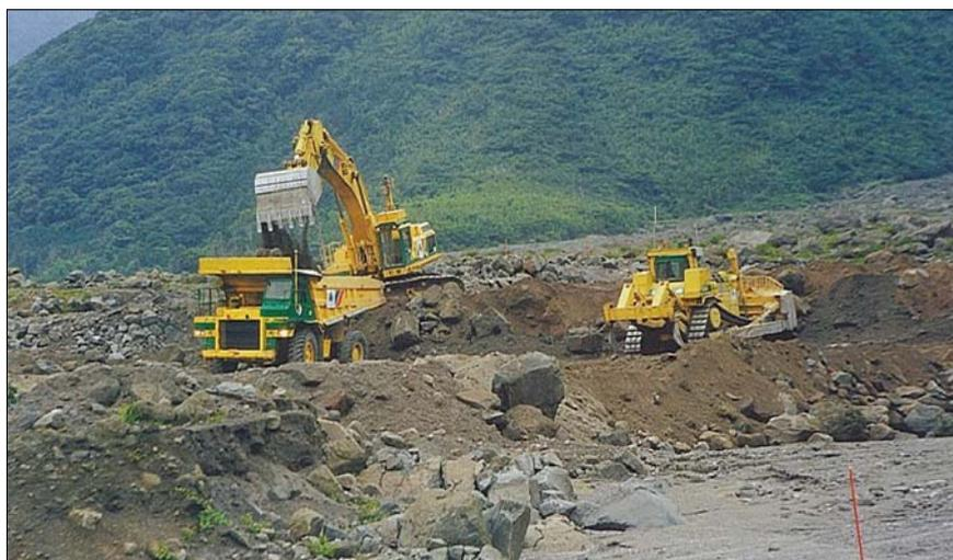
図 10 無人化施工による除石工及び砂防堰堤工の施工
