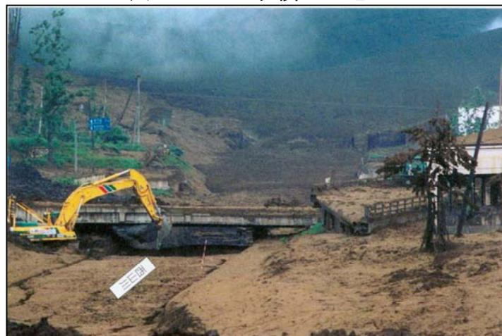
図 13 除石工の施工（無人化施工による）
