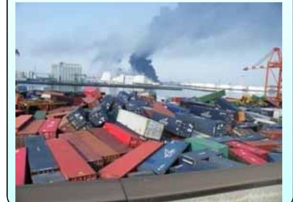
地震動、液状化による被害は、仙台湾より南部に位置する港湾で顕著であり、地震動により係留施設や護岸が被災したほか、液状化により岸壁背後のエプロンや荷さばき地が沈下し、荷役に支障が生じるなど被害がみられた。
