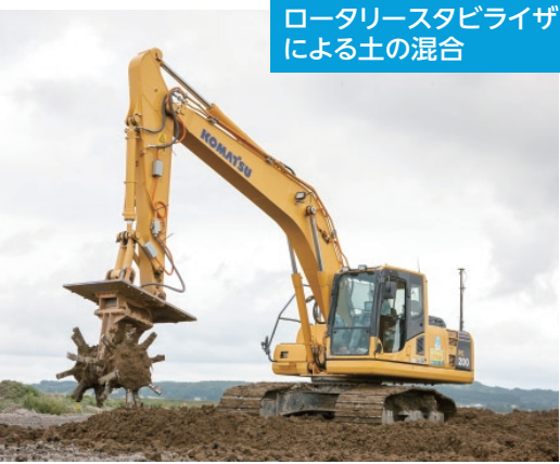
乾燥させた粘性土に砂質土を混ぜるロータリースタビライザ。広大な仮置き場で、地道な作業が続く。
