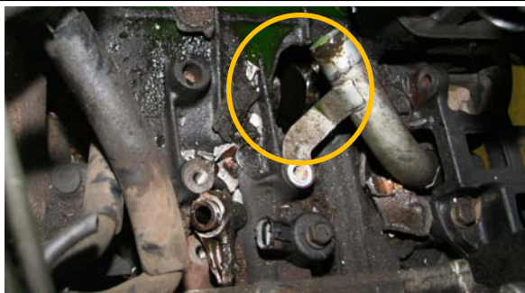
＜エンジンの破損状況＞
