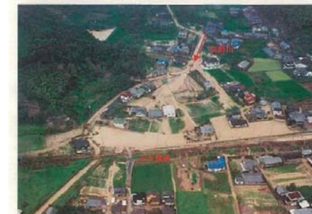
2 土砂氾濫区域全景
