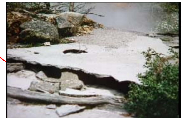
道路舗装部のひび割れ
