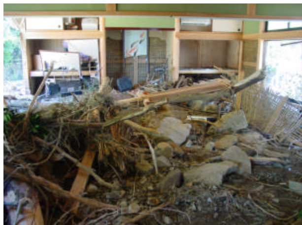
流木と土砂が覆う避難場所
