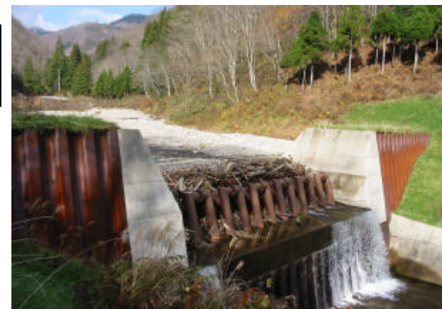
流木を捕捉した二ツ屋谷えん堤 (飛騨市宮川町)
