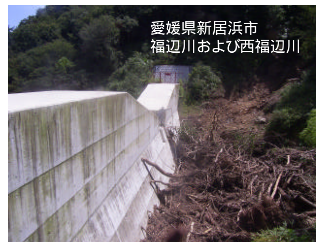
砂防えん堤が流木・土石流を捕捉
