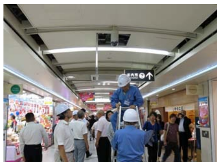
金属パネル天井
