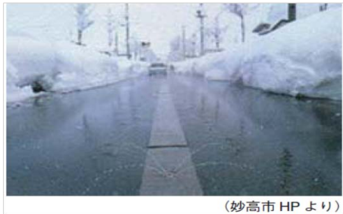
消雪用水散水状況
