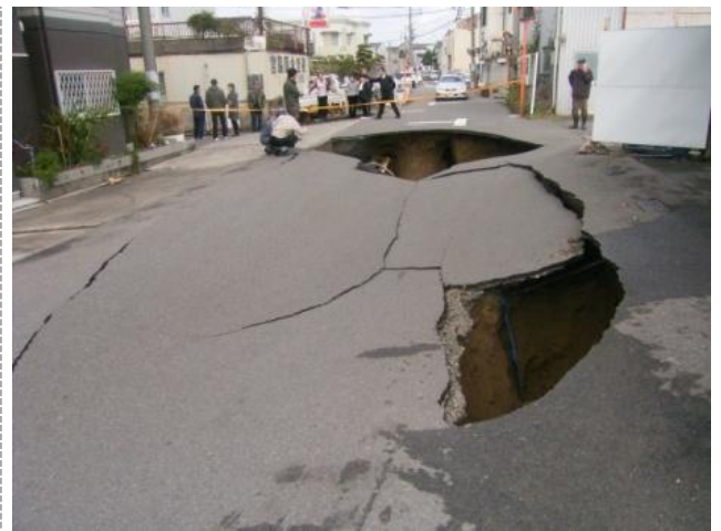
写真-1 管路施設に起因する陥没事故 (平成 23 年 3 月和歌山市)
