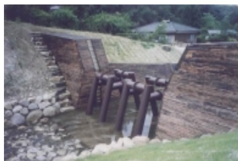
間伐材を活用した砂防施設
