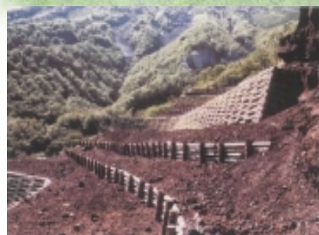
間伐材を活用した山腹工
