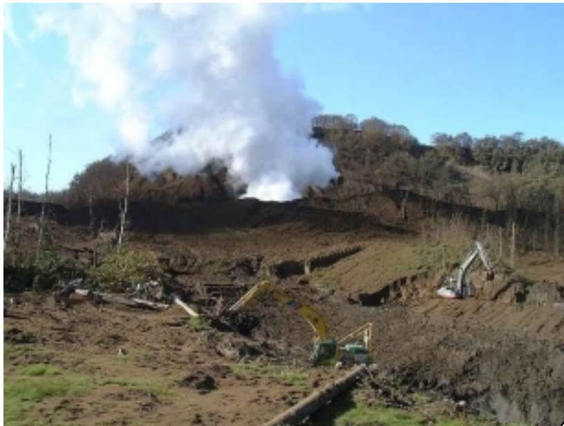
要求される危険な箇所での工事施工
