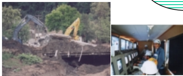
無人化施工機械による防災工事
