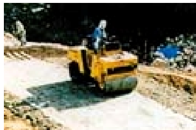
<振動ローラーによる締め固め状況>
