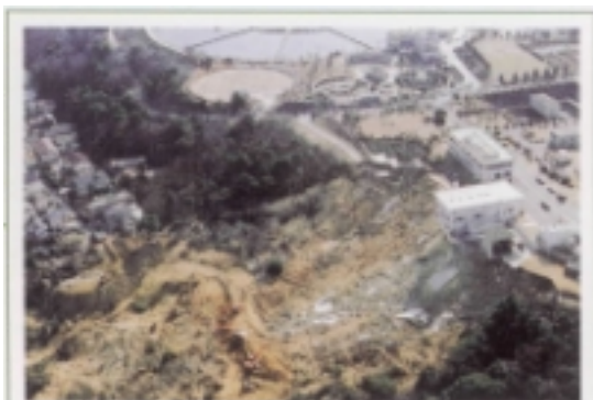
地震により地すべりが発生(西宮市 仁川)
