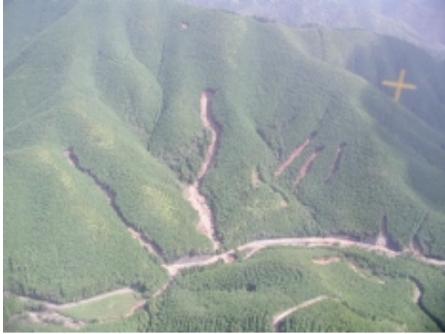
平成13年9月 高知県西南部豪雨災害 (宗呂川:土佐清水市)
