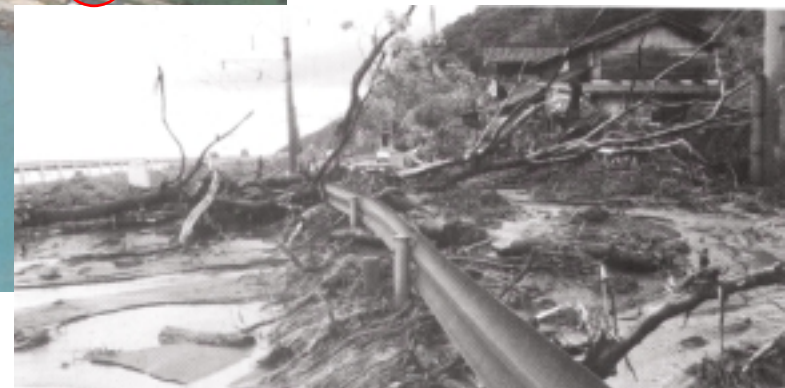
山形県温海町釜谷地区被災状況
