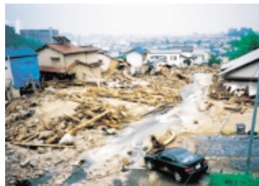
住宅地の被災状況(広島市屋代川)
