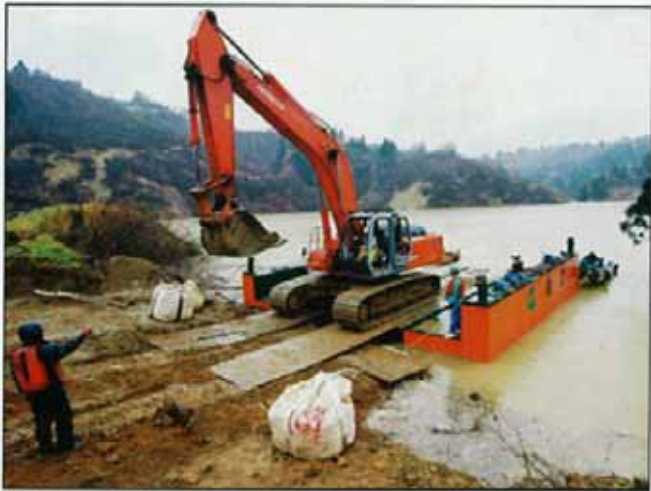
写真 台船による重機の運搬状況(11/14) (国土交通省)
