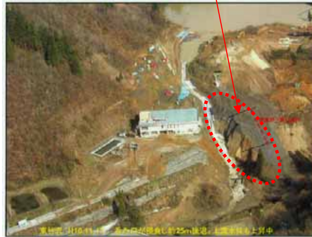
写真 ポンプ排水吐口部の侵食状況 (11/17)
