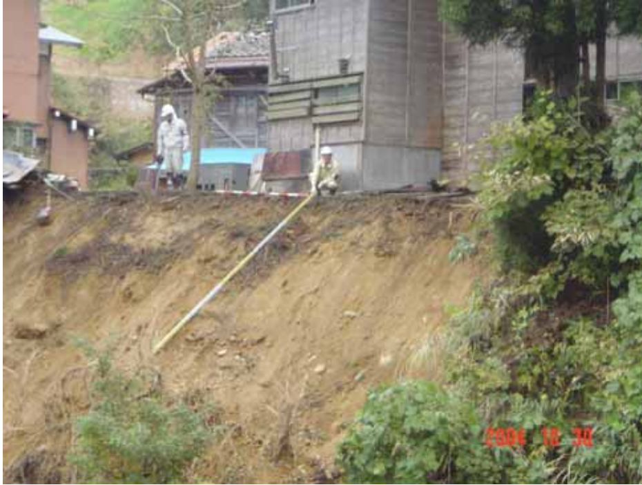
土砂災害対策緊急支援チームによる危険箇所点検(10月30日 広神村)
