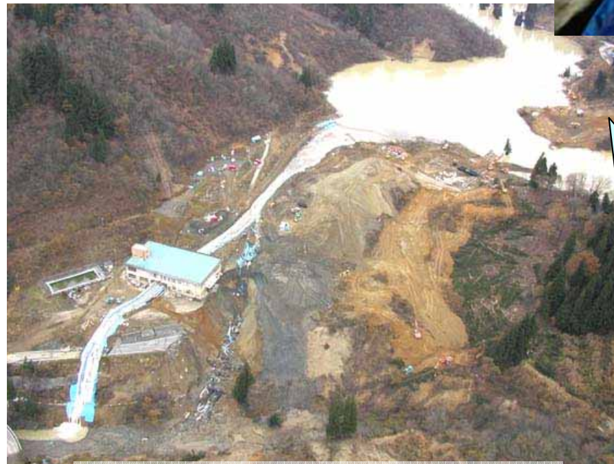
写真 ポンプ排水吐口部の付け替え完了
