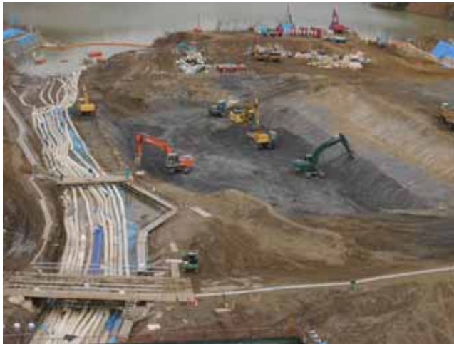
写真 仮排水路工(開水路)施工状況 (国土交通省)
