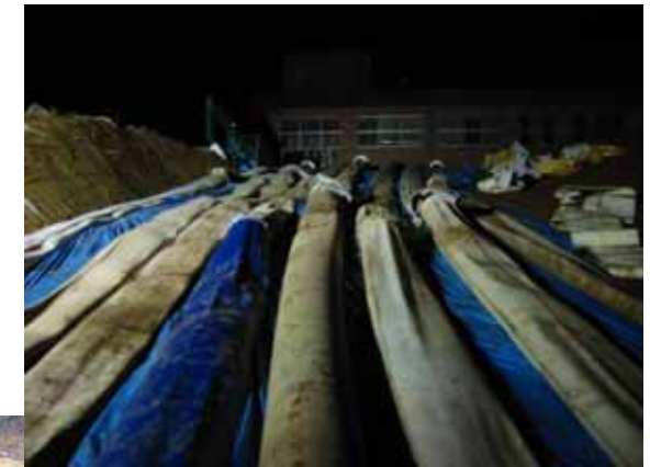
写真 付け替え作業状況 (国土交通省 直轄事務所)
