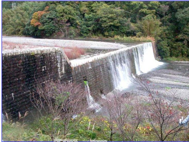
写真. 愛媛県東温市 除ヶ砂防堰堤(石積工法) 昭和10年完成、平成13年登録有形文化財に登録
