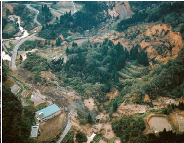
写真. H16年中越地震による地すべり災害(新潟県長岡市東竹沢地区)
