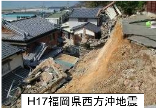
地震による斜面崩壊
