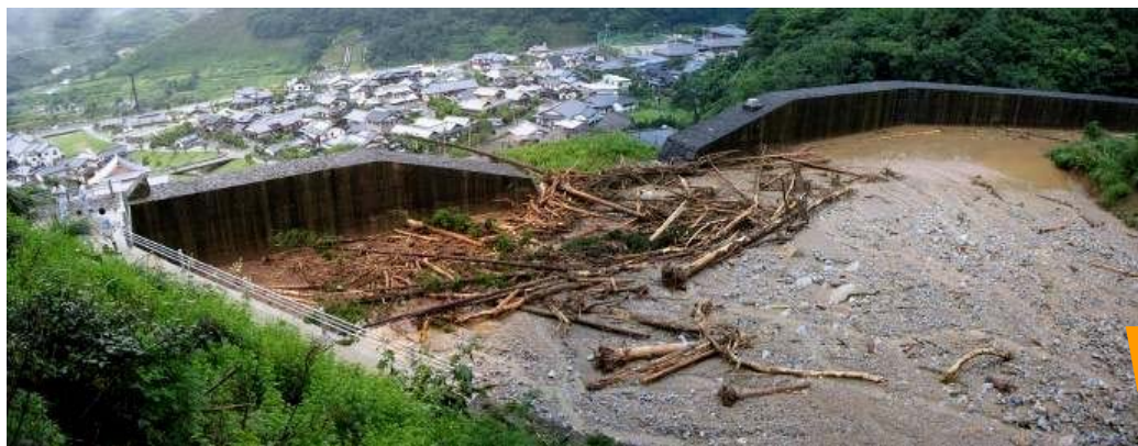
写真. H18年梅雨前線豪雨における効果事例(熊本県球磨郡:田口砂防えん堤)
