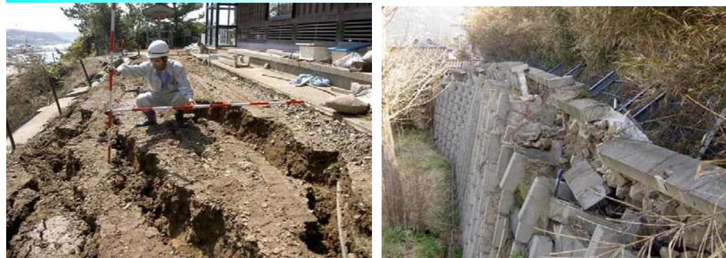
施設の破損(能登半島地震による急傾施設被災)
