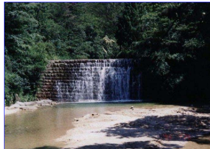
写真. 滋賀県大津市 オランダ堰堤
