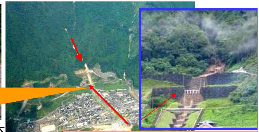
田口砂防えん堤 (H14完成)
