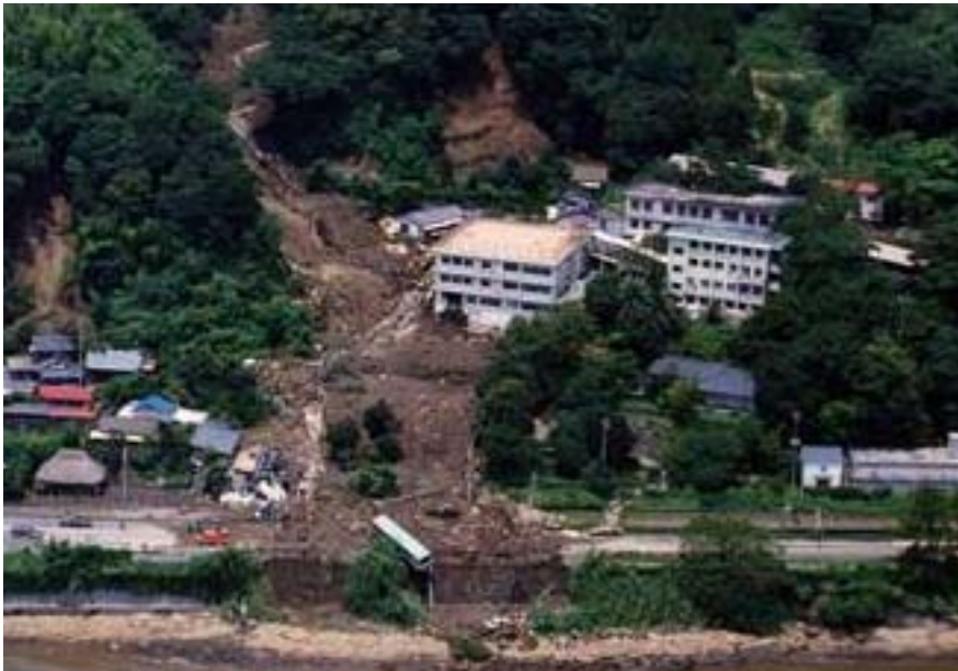
がけ崩れの直撃を受けた花倉病院 (平成5年8月豪雨 鹿児島県吉野町)
