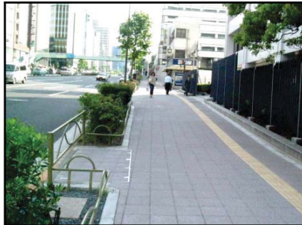
< 視覚障害者誘導用ブロックの設置 >
