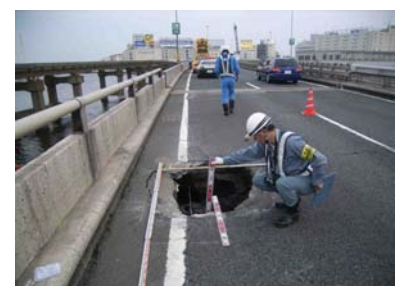
路面の陥没(平成20年発生)
