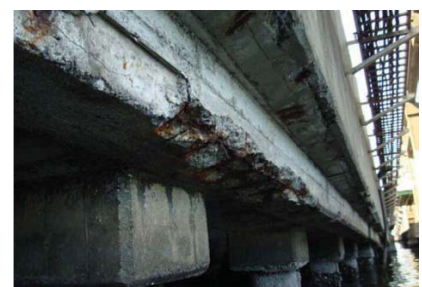
コンクリートの剥離、鉄筋腐食が発生
