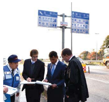
< 道路案内標識の点検の様子 >
