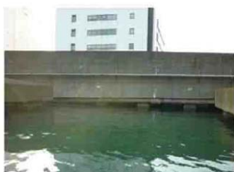
海面に最も近接している箇所 (大井埠頭橋付近)
