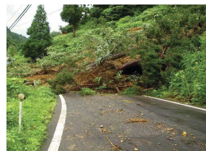
< 災害時に通行不能となった箇所 >
