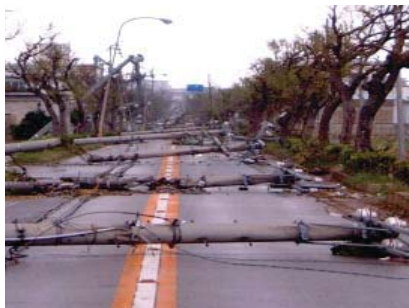
<電柱の倒壊による道路閉塞>
