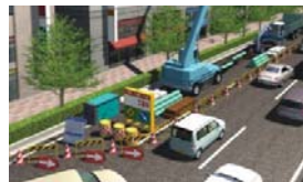
夏にガス工事
