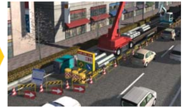
複数の工事を同時期に施工
