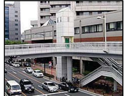
< エレベーターの設置 >
