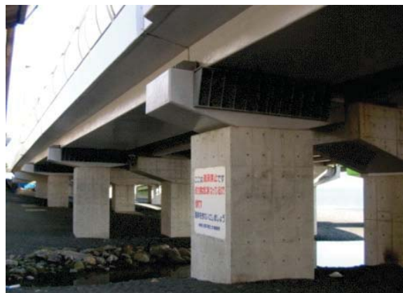
＜橋梁の耐震補強＞
