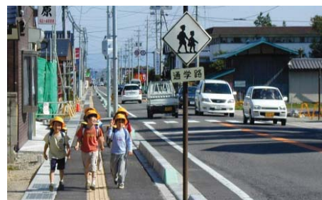
<歩道設置による安全確保の例>
