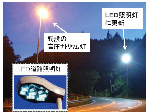
< LED道路照明灯の整備 >
