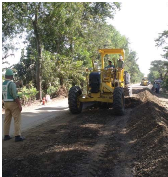
施工実演状況
