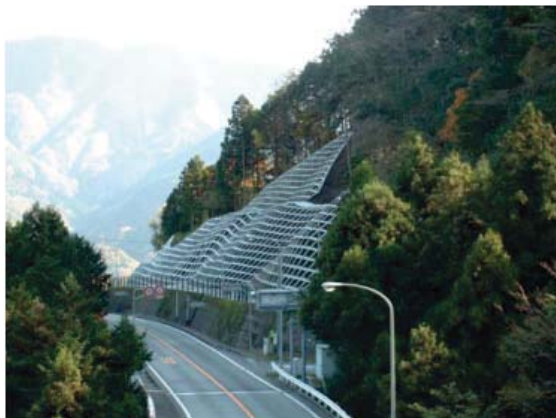
＜斜面崩落防止対策＞
