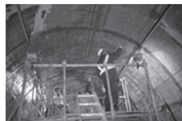
繊維シート貼付
