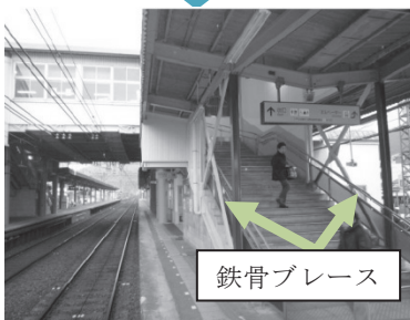
【橋上駅の補強】
