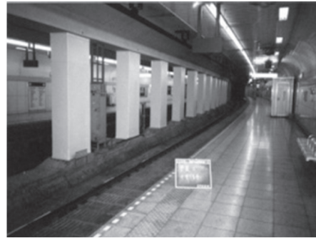
【地下鉄駅の中柱の補強】
