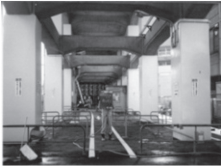
【高架橋の補強】
