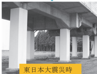
【高架橋の補強】
