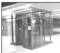
【エレベーターの整備例】
