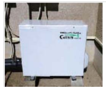
地下水熱ヒートポンプ
