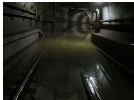
平成25年9月 京都市営地下鉄の浸水状況
