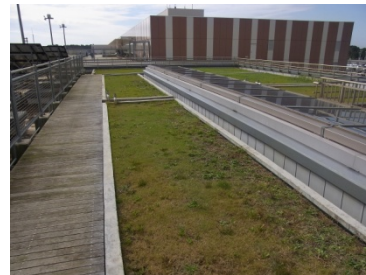
■ 屋上緑化（空港事務所ビル）
