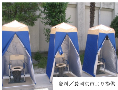
公園へのマンホールトイレの設置, [事例3-7より]
