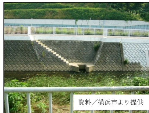
河川護岸を改良して消防用水利用施設を設置 [事例1-3より]
