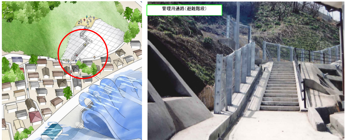
急傾斜地対策施設の管理用階段の活用
