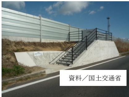
既存道路に避難階段を設置 [事例2-1.4より]
