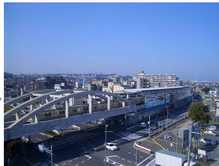
鶴川街道 高架切替後
