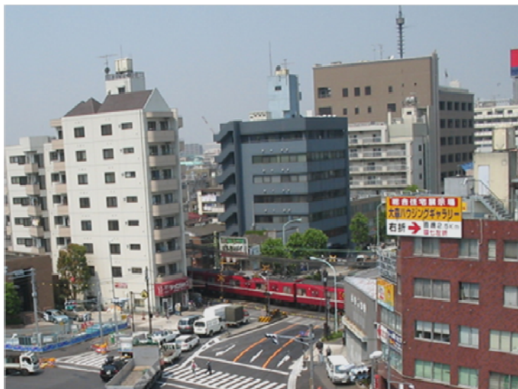
環状八号線 仮線高架切替前
