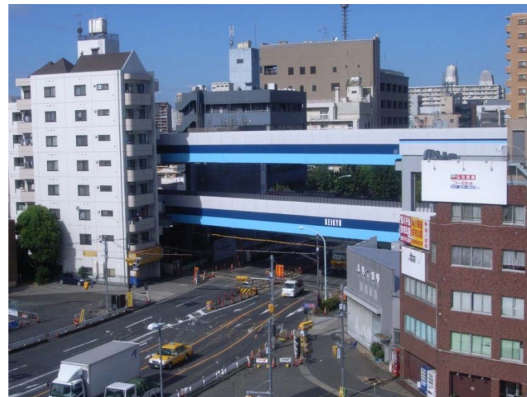
環状八号線 仮線高架切替後
