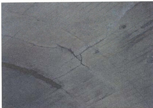
写真-4.3.5 複数のひび割れで覆工コンクリートがブロック化している例
