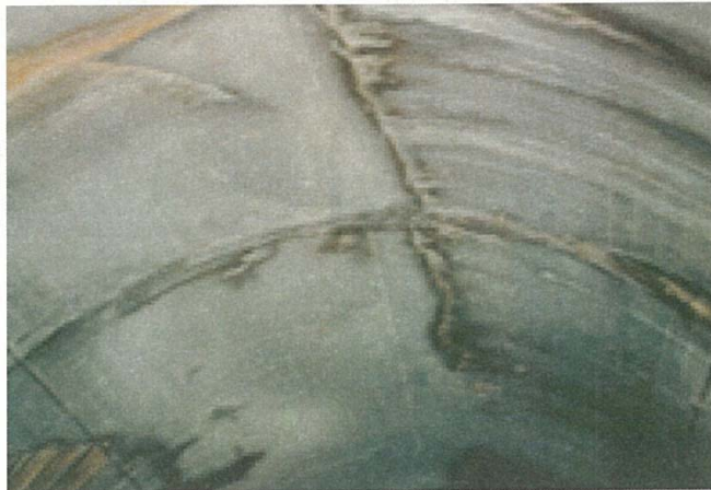
写真-4.3.3 覆工の天端付近に発生した縦断方向のひび割れの例
