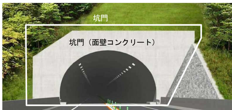
図-4.2.2 点検対象箇所（トンネル坑口部）
