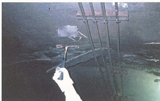
写真-4.3.9 補修モルタルが劣化してはく離している例
