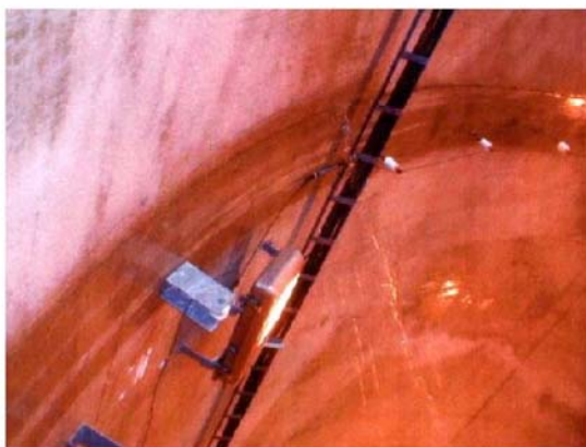
写真-4.3.7 漏水（噴出）している例
