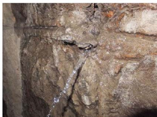
写真-4.3.7 漏水（噴出）している例
