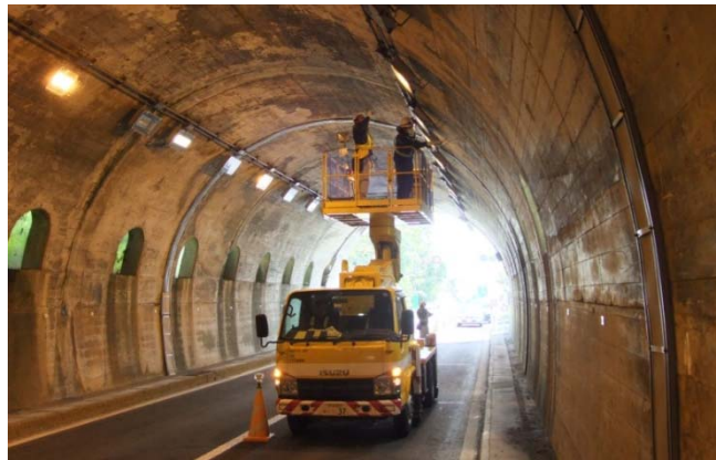
写真-4.1.1 近接目視作業状況
