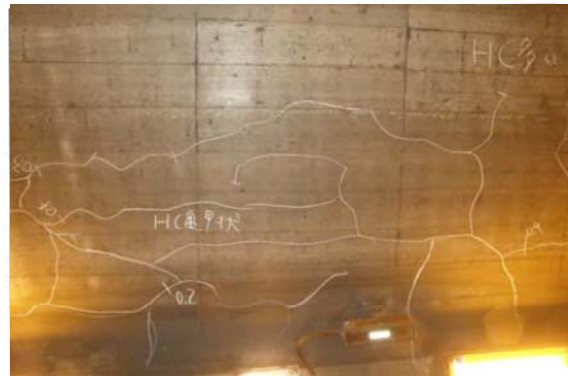
写真-4.3.5 複数のひび割れで覆工コンクリートがブロック化している例
