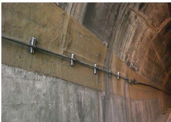
写真-4.3.10 鋼板接着（左）・繊維シートの接着（右）例
