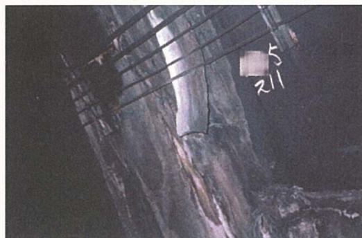
写真-4.3.9 補修モルタルが劣化してはく離している例
