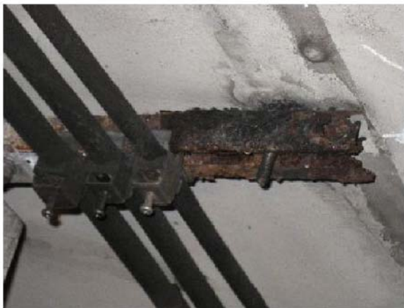
写真-4.3.12 固定金具の腐食とアンカーボルトの脱落の例
