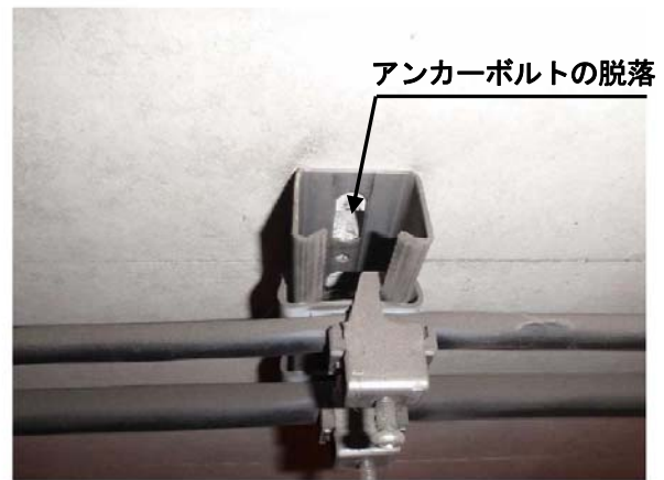
写真-4.3.12 固定金具の腐食とアンカーボルトの脱落の例
