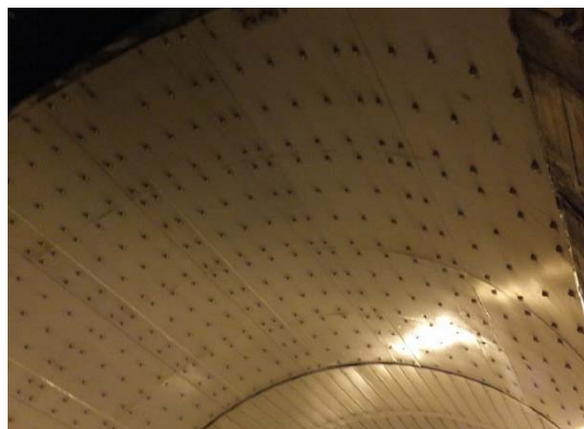
写真-4.3.10 鋼板接着（左）・繊維シートの接着（右）例
