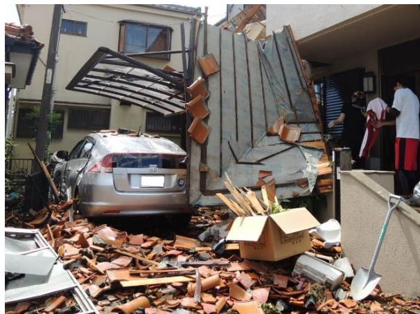
写真 4.3.4 隣家から飛散した屋根
