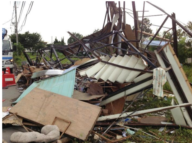
写真3 飛散した上部構造
