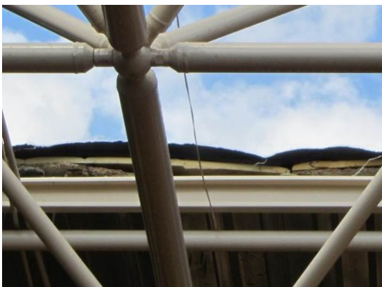
写真 4.1.5 屋根ふき材の断面
