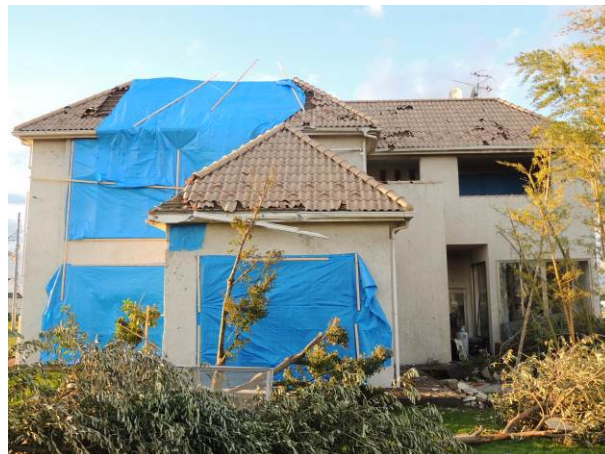
写真 4.2.13 屋根及び開口部の応急措置の状況
