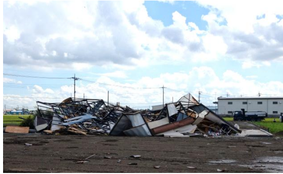
写真1 軽量鉄骨造倉庫の被害（室井公美子氏提供）
