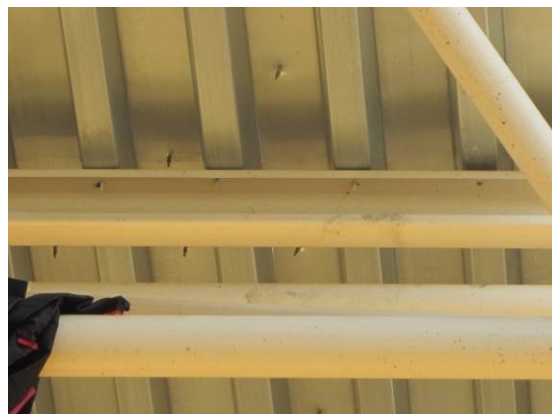
写真 4.1.6 屋根ふき材と母屋との接合部（ビス）
