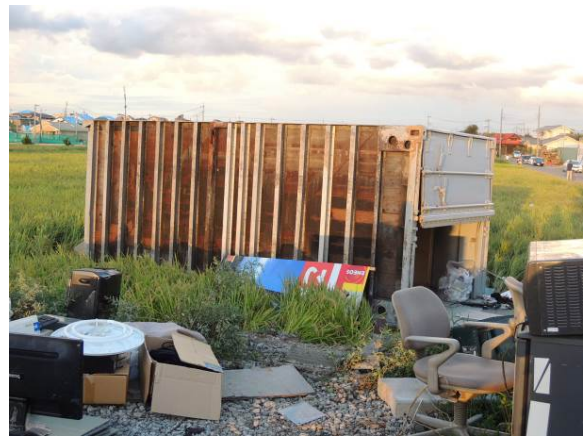
写真 4. 4. 2 転倒した鋼製コンテナ (2)
