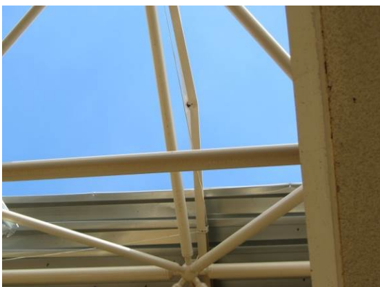
写真 4.1.7 母屋の変形
