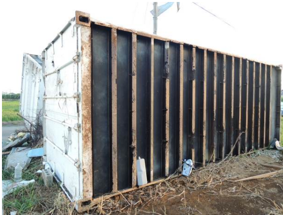
写真 4. 4. 1 転倒した鋼製コンテナ (1)
