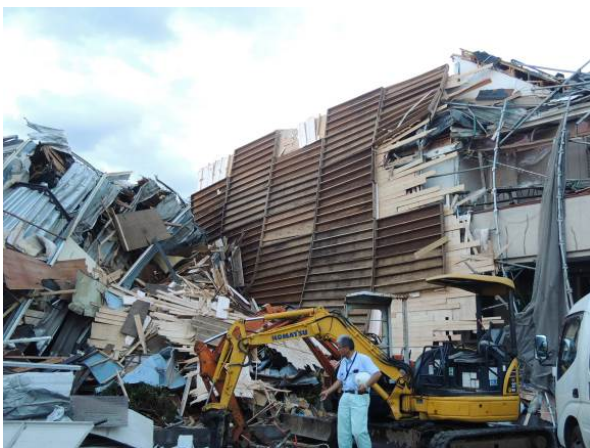
写真 4.2.3 上部構造の飛散
