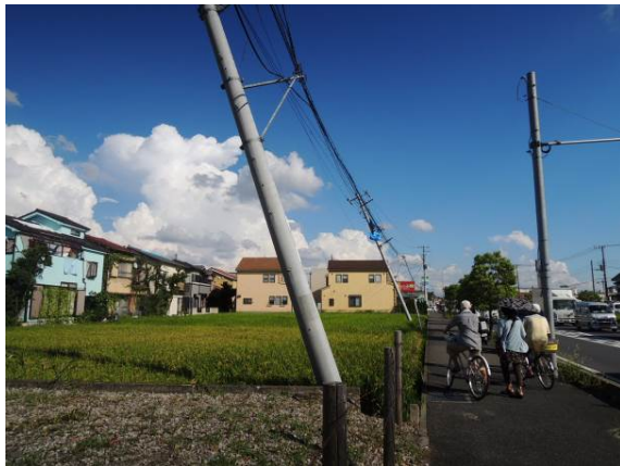
写真 4. 4. 3 電柱の傾斜
