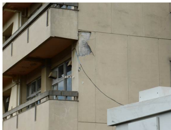
写真 4.1.1 本校舎外観及び窓ガラス被害 写真 4.1.2 本校舎の仕上げモルタルの剥落
