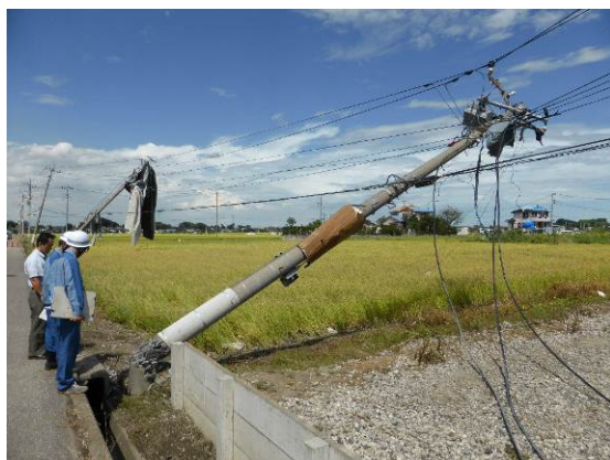
写真 4. 1. 10 電柱の倒壊
