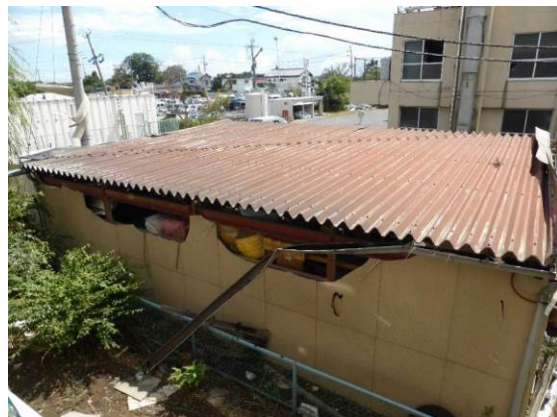
写真 4. 1. 24 建築物背後の倉庫
