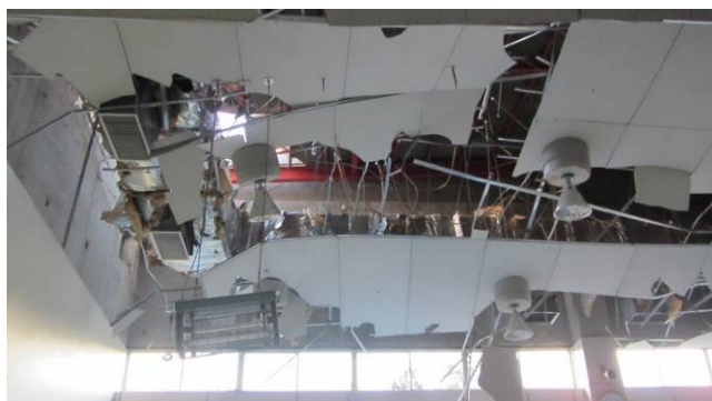
写真 4. 1. 28 天井の破壊
