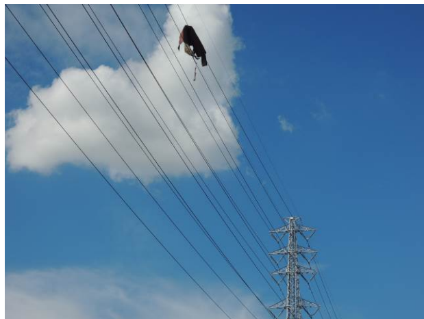
写真 4.3.2 電線に引っ掛かった外装材
