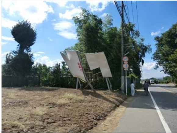
写真 5.2.18 看板の被害
