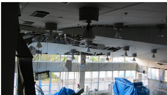
写真 4. 1. 28 天井の破壊
