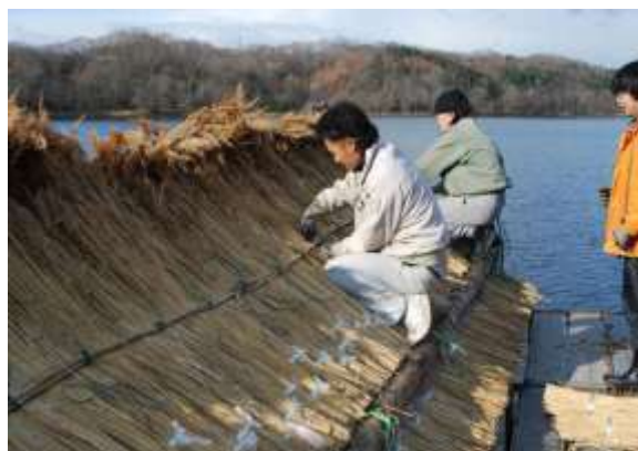
舟小屋の屋根のササ葺き作業
