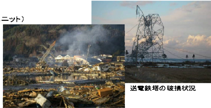
津波等による送電設備の被災状況 送電鉄塔の破損状況 停電の一例) 洋野町種市病院 停電時間 32時間 久慈市久慈病院 停電時間 30時間 (資料: 船舶を利用したスマートグリッド 東京海洋大刑部教授)
