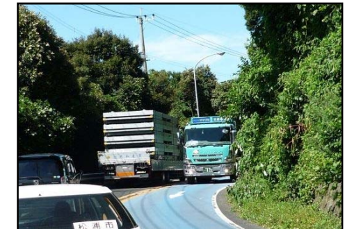
写真1 平面線形不良箇所（国道204号）
