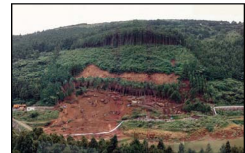
写真2 法面崩壊状況（江迎地区）H3.6.9
