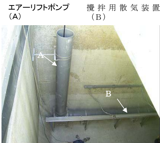
エアールフトポンプと散気装置
