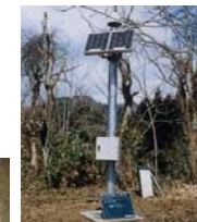
GPSを活用した地すべり監視
