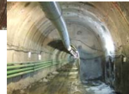
地すべりの動きを止めるための深礎杭施工、排水トンネルの設置
