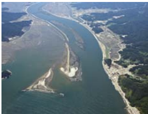
東日本大震災での浸水被害
