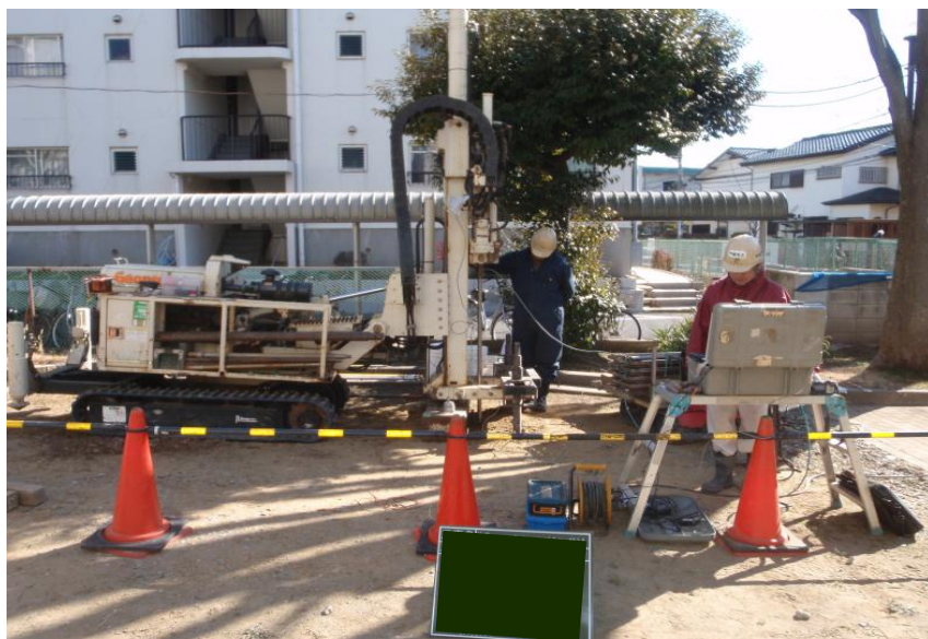
地盤調査状況
