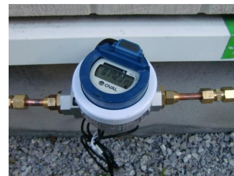
写真.微流量燃料油メーター（ケロメイト） 取り付けの様子
