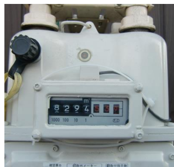
写真.簡易ガス流量センサー（GasCT） 取り付けの様子
