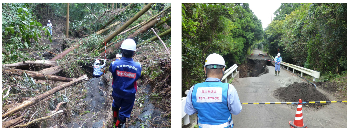
図-24 台風26号災害（伊豆大島）におけるTEC-FORCEによる現地被災調査
