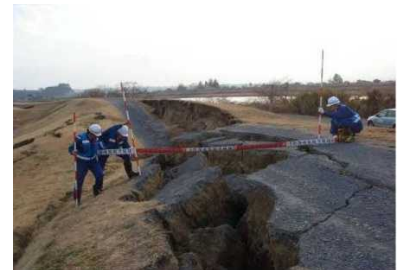
被災状況調査班 (河川班)
