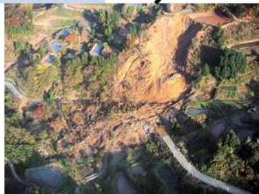
中山間地域では土砂崩壊で交通網が寸断されこれに通じる集落は孤立することが考えられる。
