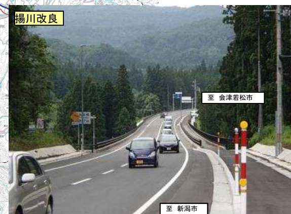
会津若松市方面を望む (H25.3.30全線開通)
