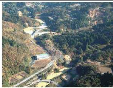
急峻な斜面下を流れる河川では土砂崩壊による河川閉塞が発生。
