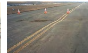
揺れによる誘導路の陥没
