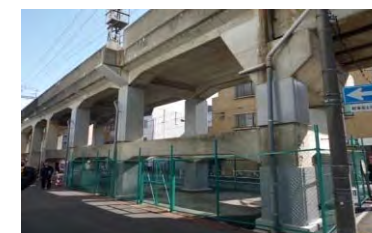
高架橋の橋脚補強 (鋼板巻き補強)
