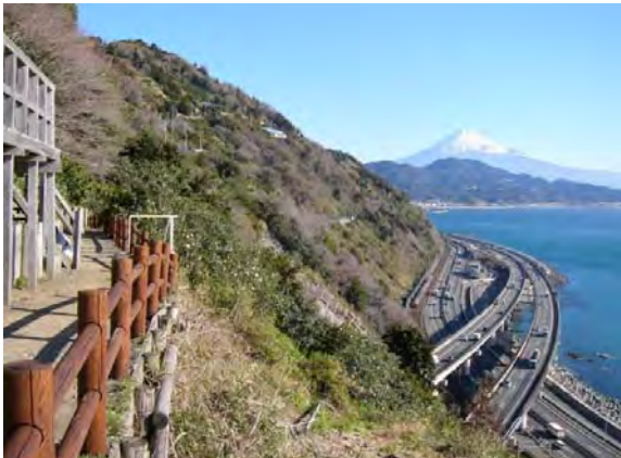
国道1号、東名高速道路、JR東海道本線及び情報通信網が集中している静岡県由比地区
