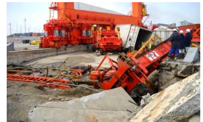
地震・津波で被災したコンテナ岸壁 (仙台塩釜港(仙台港区))
