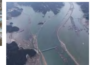
津波による大規模浸水
