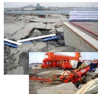
岸壁・荷役機械の被災
