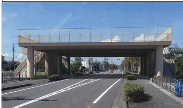
津波避難施設 (道路上に設置される津波避難施設)
