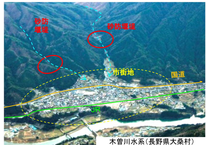
砂防堰堤による土砂崩壊対策
