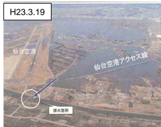
仙台空港被災状況
