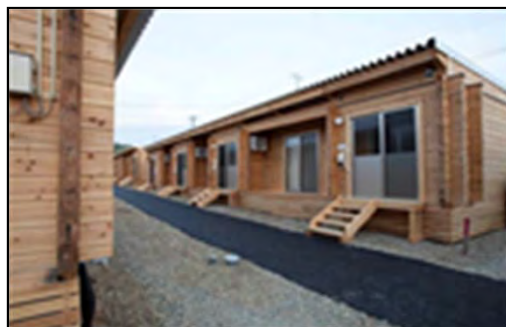
被災者向け住宅 (東日本大震災)
