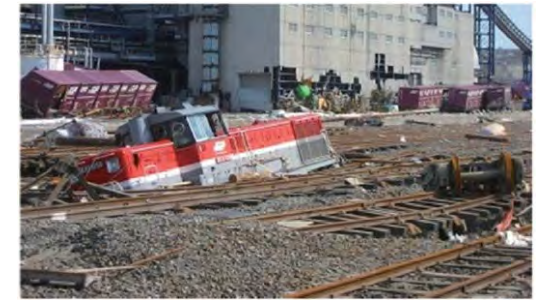
東日本大震災における津波による貨物鉄道の被害状況
