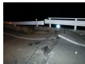
揺れによる橋梁等の被災
