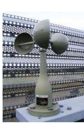
【風速計の増設】
