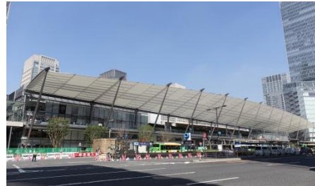
東京駅八重洲口グランルーフ (2013年9月)
