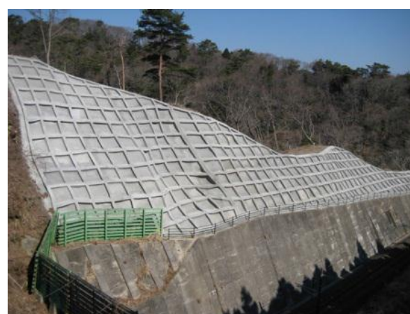
【降雨防災対策】
