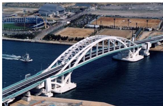
旋回式浮体橋
