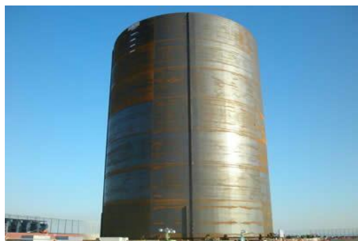
鋼板セル(護岸・防波堤)
