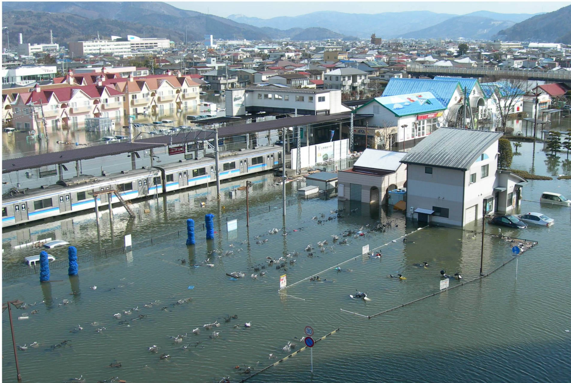
川から離れたJR石巻駅が5日間も津波により浸水。もともと低平地盤であった石巻市街地が、地盤沈下によってさらに低くなった。
