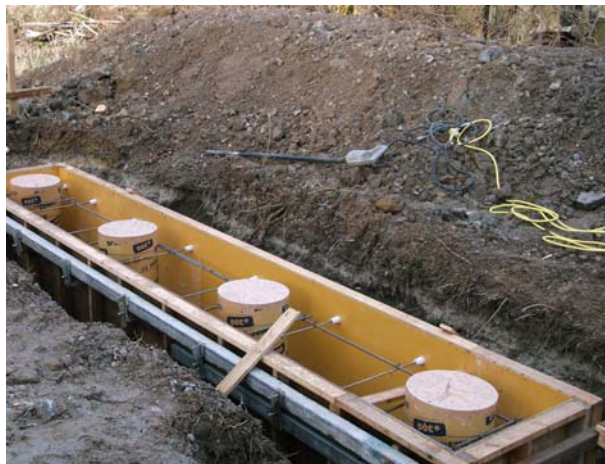
木造支柱の基礎作業
