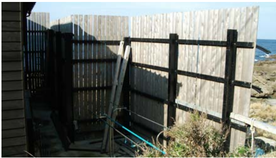
写真 1-8 鉄骨+板垣に変更された間垣(裏面)
