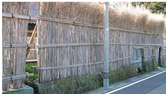
写真 1-6 伝統継承タイプの間垣
