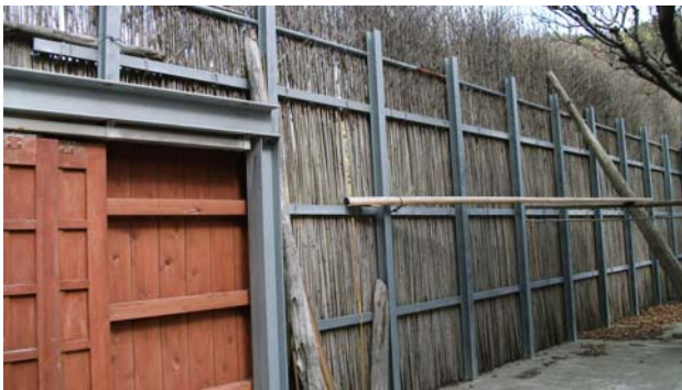
写真 1-12 支柱・横材が鉄骨に変更された間垣
