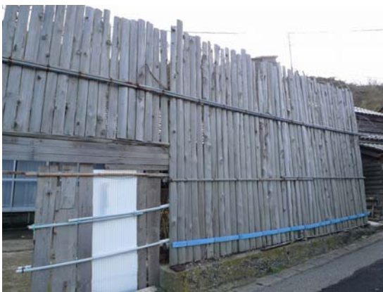
補修前の板のみの間垣(No.34)
