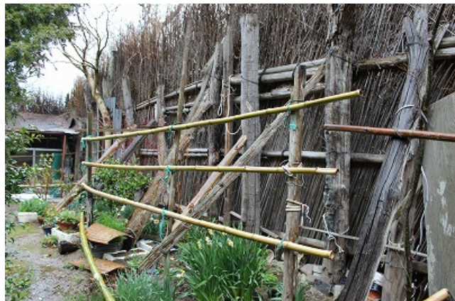
写真 1-13 伝統継承タイプの間垣には、支柱を支えるナナメ材が用いられている
