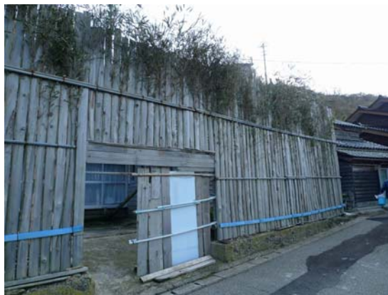
補修後の板塀の間垣。ニガタケが少ないものの、多少の修景効果が見られる
