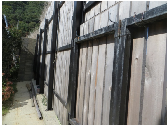
写真 2-2 実存の鉄骨造の間垣①
