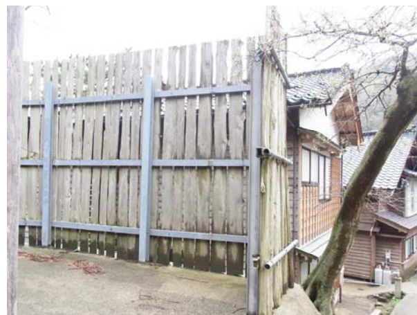
写真 1-2 支柱に鉄骨が使用されている間垣
