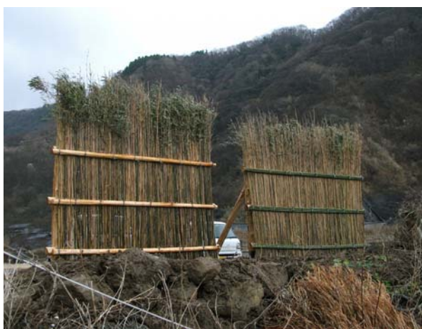
完成した試験的間垣(左:Bタイプ、右:Aタイプ)
