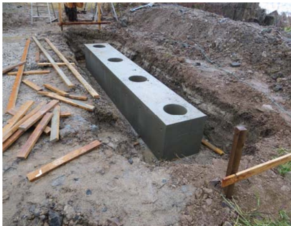
木造支柱の基礎の埋め戻し
