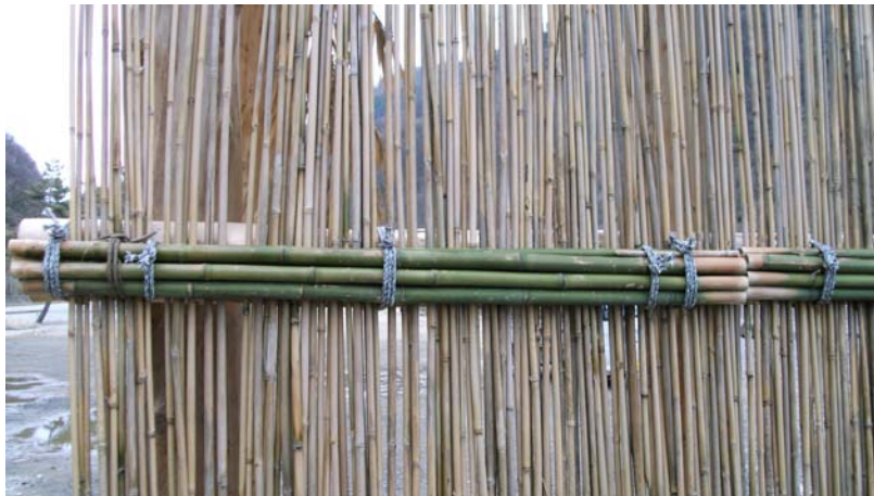
押え材は5本の竹をまとめてあり3カ所で背面の横材とロープで固定されている
