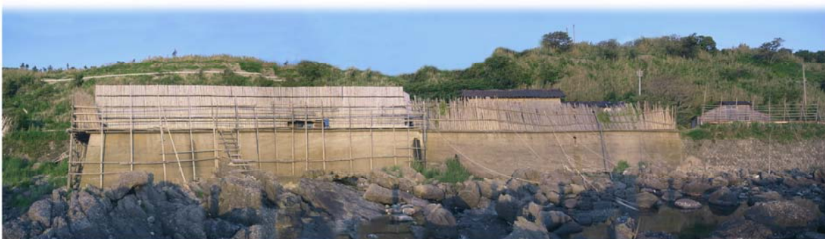
写真 1-3 大沢町長手の擁壁上の間垣
