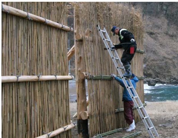
横材のロープを切り、解体作業を進めている様子
