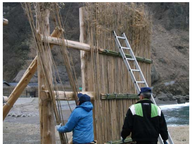
解体された間垣の様子
