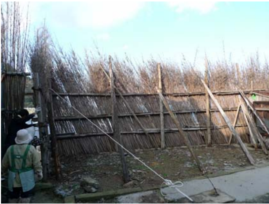
補修前の伝統的な間垣(No.32)
