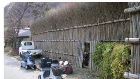
写真 1-11 伝統継承タイプの間垣
