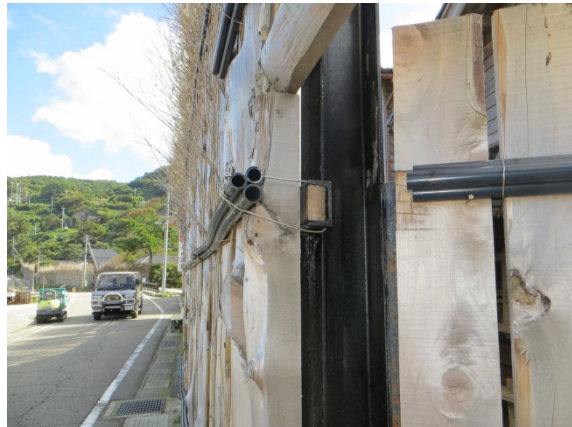
写真 2-3 実存の鉄骨造の間垣②
