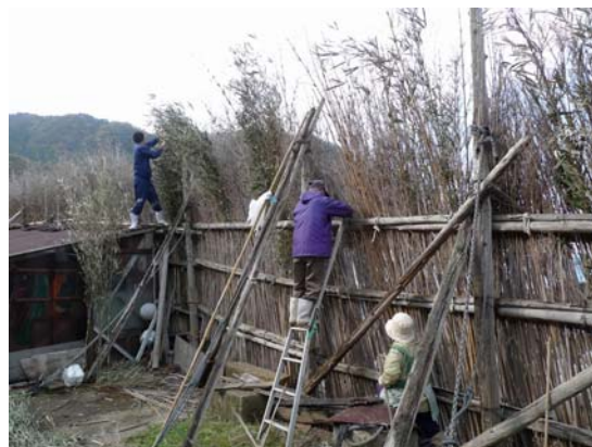
補修作業の様子
