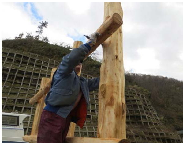
支柱と横材のボルト留め作業
