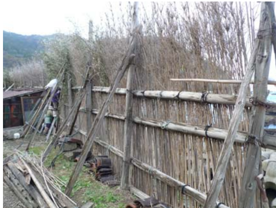
補修後の間垣
