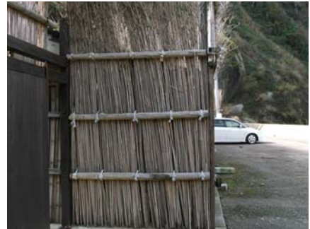
曲がり角に設置された間垣
