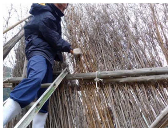
古くなったニガタケを取り除く作業中
