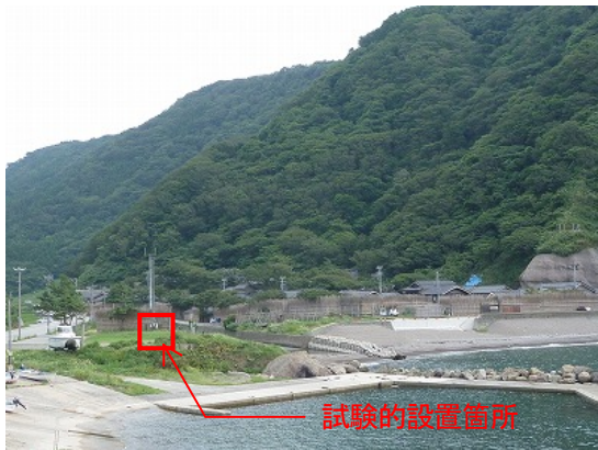
写真 3-1 試験的設置箇所
