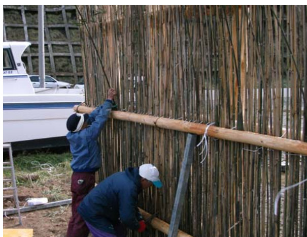
押え材とニガタケの設置作業
