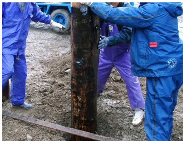
木造支柱の設置作業
