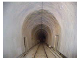
コンクリート吹付工
