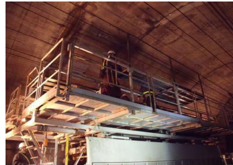
【トンネル天井部の点検の様子】
