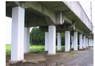
【高架橋の補強】
