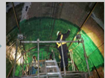
繊維シート貼付
