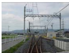
行き違い設備
