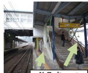
鉄骨ブレース
