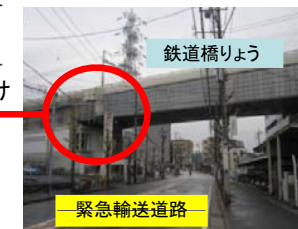
【橋りょうの補強】
