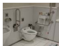
障害者対応型トイレ
