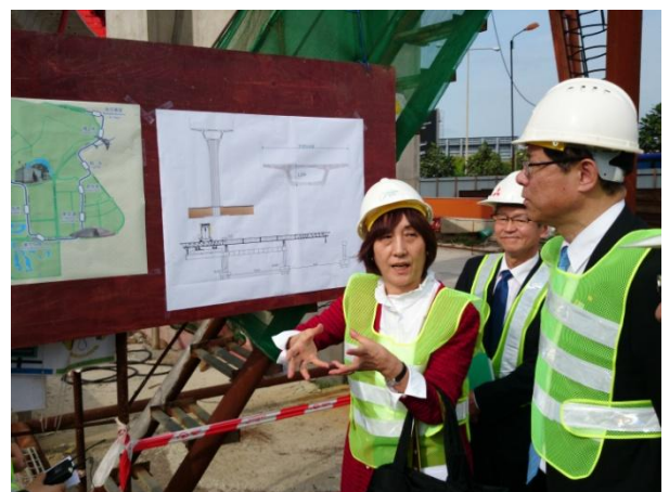
マカオ：L R T 建設現場視察
