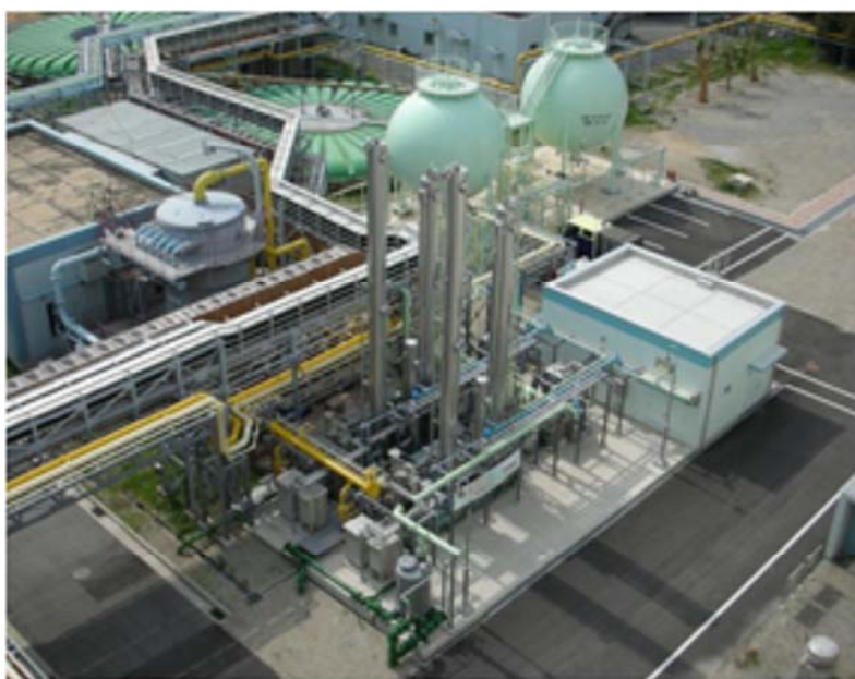
図 4. 209 バイオ天然ガス化装置（神戸市東灘処理場）
