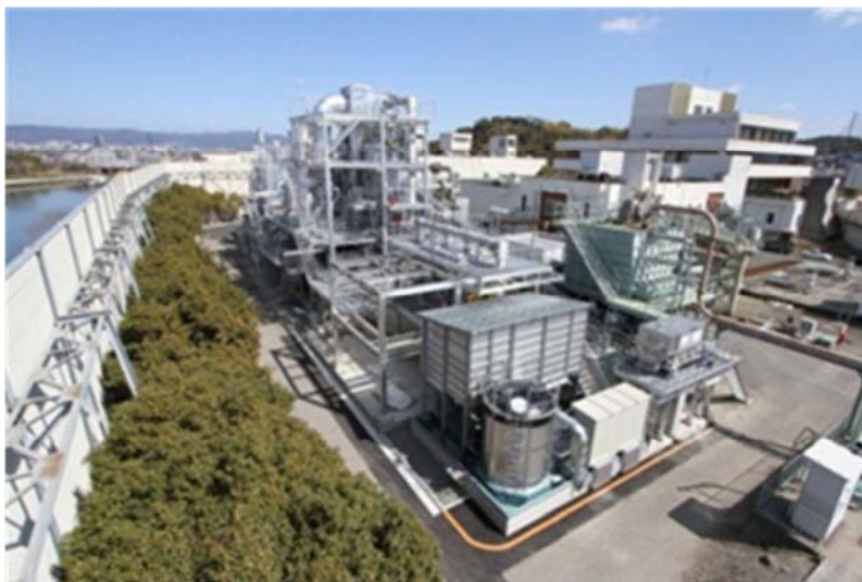
図 4.214 低含水率脱水による焼却炉の自燃化 (B-DASH、和歌山市中央終末処理場)
