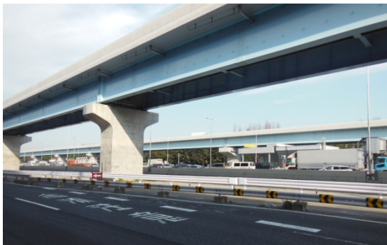
図表 1-2-2 国道 357 号新木場立体 (平成 26 年 3 月時点)
