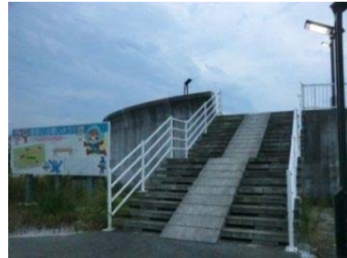
避難マウンドの機能強化事例 (照明・備蓄倉庫)
