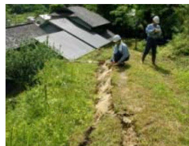
TEC-FORCEによる緊急点検・対策
