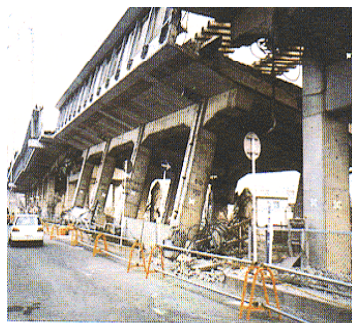
高架橋耐震補強
