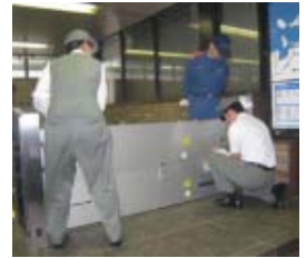
止水板の設置等
