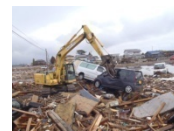
建設業界・レッカー業界等との連携(協定制度の活用)
